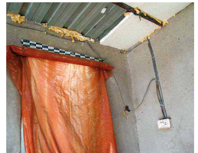
Isolierung in Khalids 1-Zimmer-Wohnung
