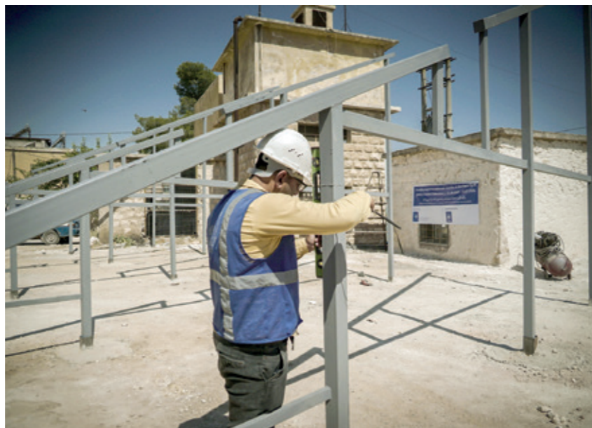
Ein Ingenieur bei der Installation der Solarbetriebsanlage für das Wassersystem
